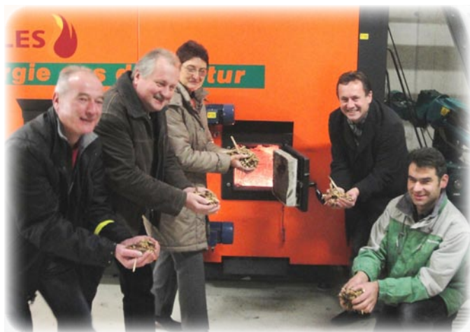
von links nach rechts: Hannes Pichler - Heizungsinstallation, Gerhard Thaler - Elektroanschluss, Amtsleiterin Sonja Assmann, Bgm. Ernst Lehner und Josef Denkmaier von der Bioenergie Katsdorf.
